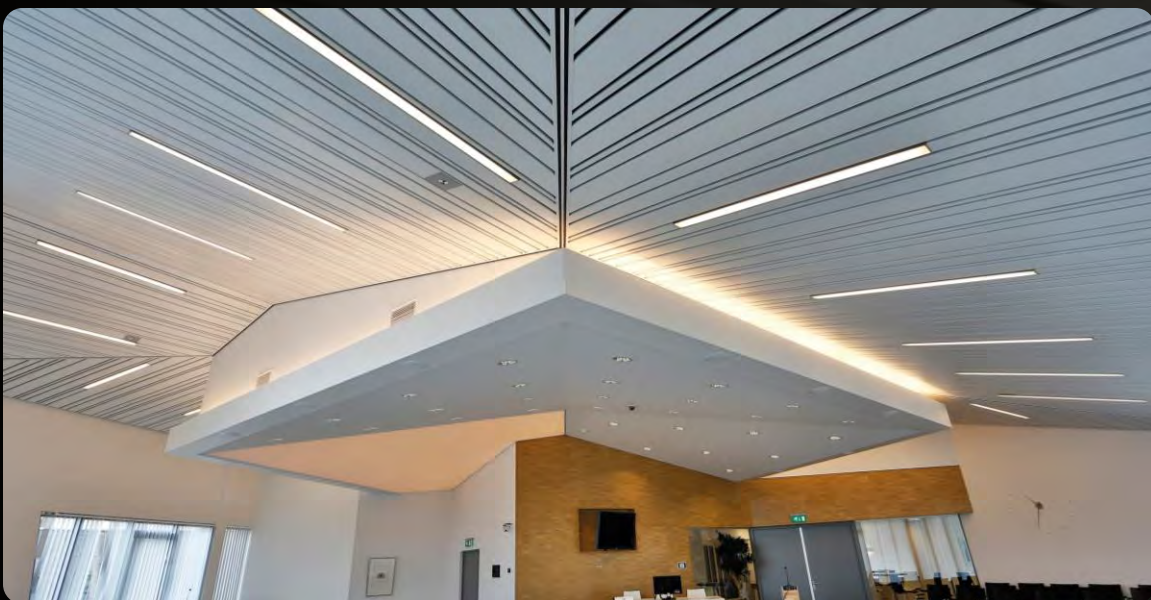
Стандартный монтаж реечного потолка французского S-дизайна
